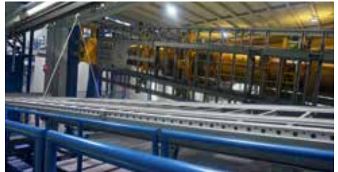
Po izhodu iz komore avtomatizirana naprava trese šasije, da odpadejo vse kroglice in nečistoče.
